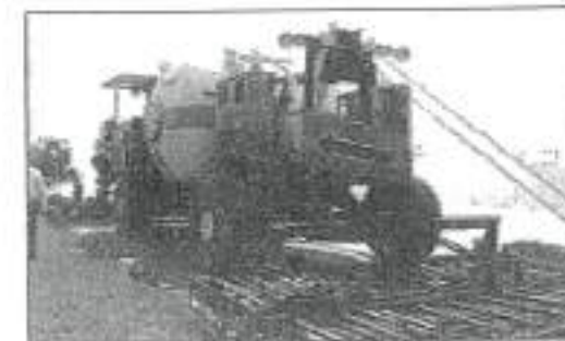
รูปที่ 8 เครื่อง Pre-heater
