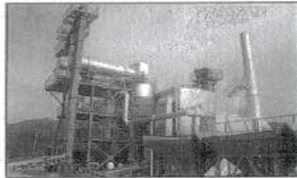
รูปที่ 5 Central Plant หรือ Batch Plant สำหรับผลิต Hot Mix Recycling โดยภาพ
