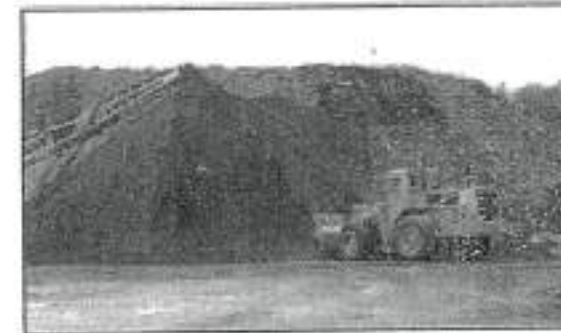
รูปที่ 3 การย้ายชั้นทางแอสฟัลต์คอนกรีตเดิม แล้วนำไปทำ Stock Pile
