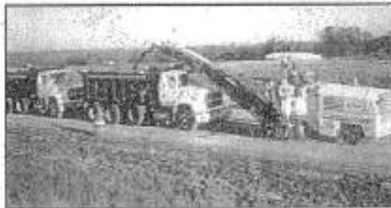
รูปที่ 2 การรื้อหรือตัดขึ้นทางและสิ่งสกปรกเดิมแบบเย็น (Cold Milling)
