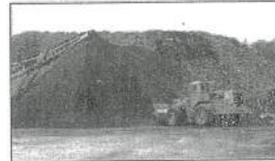
รูปที่ 3 การรื้อหรือตัดขึ้นทางและสิ่งสกปรกเดิม แล้วนำไปทำ Stock Pile
