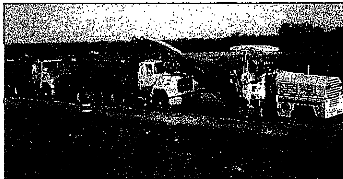
รูปที่ 2 การรื้อหรือตัดชั้นทางแอสฟัลต์คอนกรีตเดิมแบบเย็น (Cold Milling)
